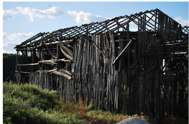
Figura 4. Secadero de tabaco de la Vega de Granada. Su evidente interés patrimonial está en riesgo. Fuente: Foto del autor.
