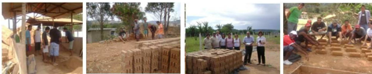
Figura 4: Etapas do processo de fabricação dos adobes e blocos de terra compactada. Fonte: GEAHAS, 2007.
