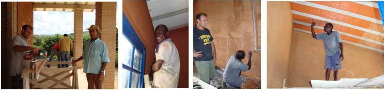
Figura 7: A execução das esquadrias, colocação da rede hidráulica e pintura da moradia. Fonte: GEAHAS, 2009.
