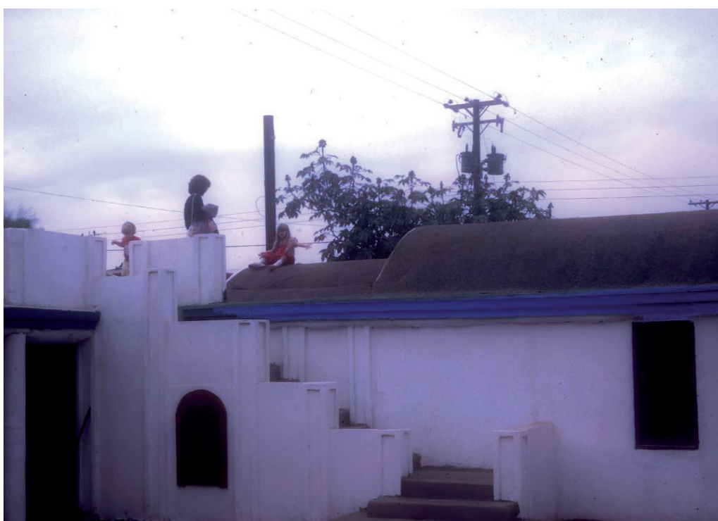
FIGURA 5 Patio del obrador comunitario, vista de la escalera hacia la terraza. Fuente: livingneighborhoods.org recuperado de https://www.livingneighborhoods.org/ht-0/mexicali.htm
