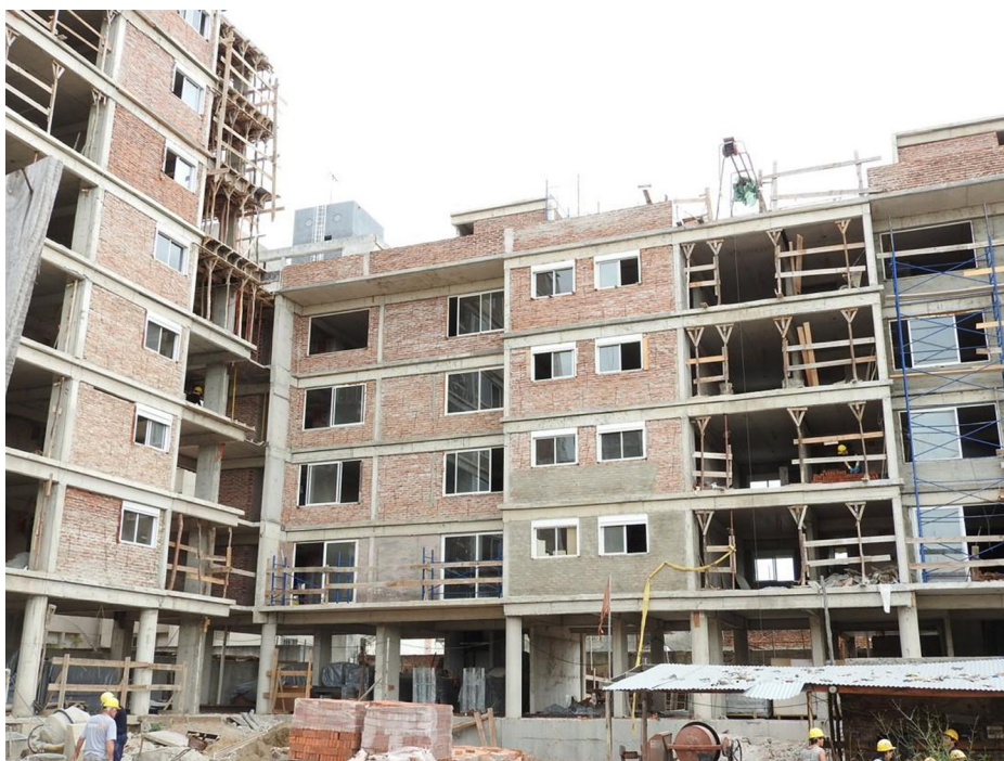
Figura 4: Construcción en altura por ayuda mutua. COVIVEMA 5, Montevideo. Fuente: Archivo FUCVAM s/d.
