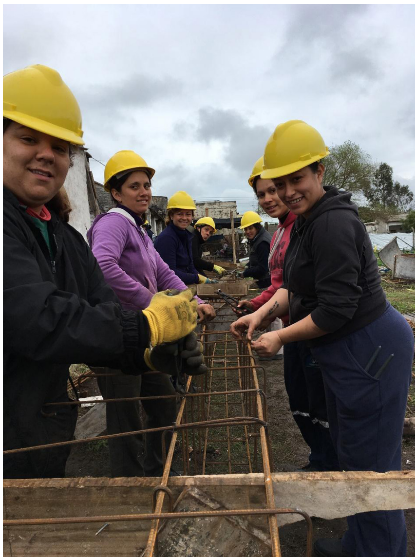
Figura 1: Ayuda Mutua. Participación de la mujer. Confección de armaduras para vigas y pilares. Fuente: Archivo FUCVAM, autoría de Gustavo Castagnello.
