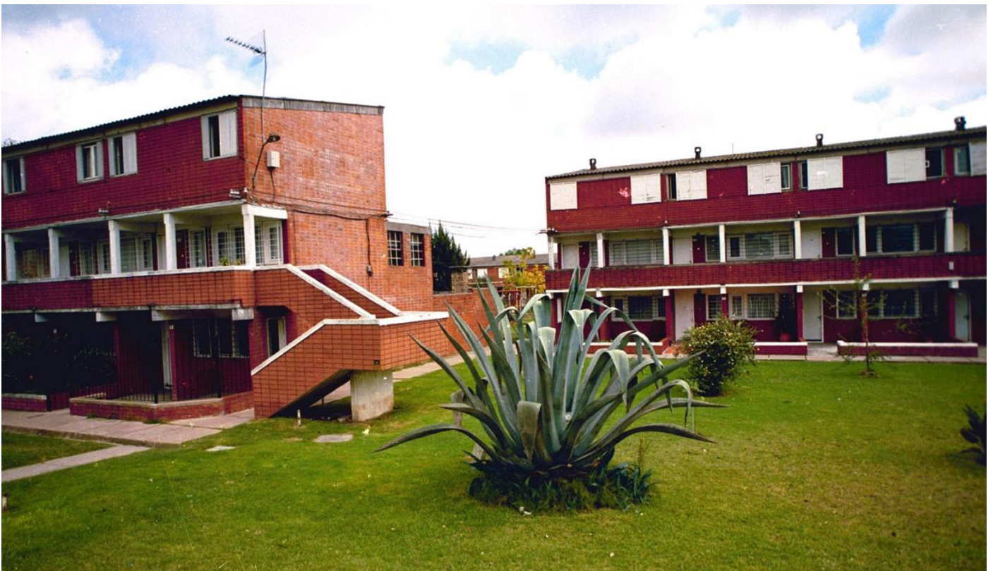
Figura 3: Conjunto Intercooperativo "Mesa 2", 420 viviendas, Montevideo. Fuente: Archivo FUCVAM, autoría de Gustavo Castagnello.
