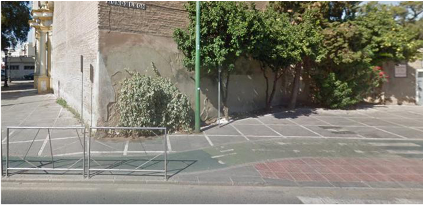
Figura 2. Carril-bici en calle Muñoz León. Previamente el acerado era mucho más estrecho y era ocupado en su totalidad por un angosto carril-bici que lindaba con la esquina sobresaliente del edificio, haciendo imposible el paso de un peatón y una bicicleta al mismo tiempo y propiciando posibles atropellos. El nuevo trazado gana espacio a la calzada, permitiendo un leve desvío del carril-bici y destinando al paso peatonal el espacio que antes ocupaba la vía ciclista. Para la resolución del problema, se mantuvo la angostura del carril-bici. Foto recuperada de Google Maps.
