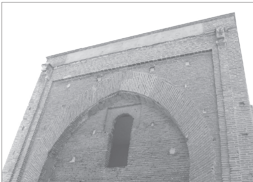
Fig. 25. La puerta de las Huelgas, vista desde intramuros de la villa.
