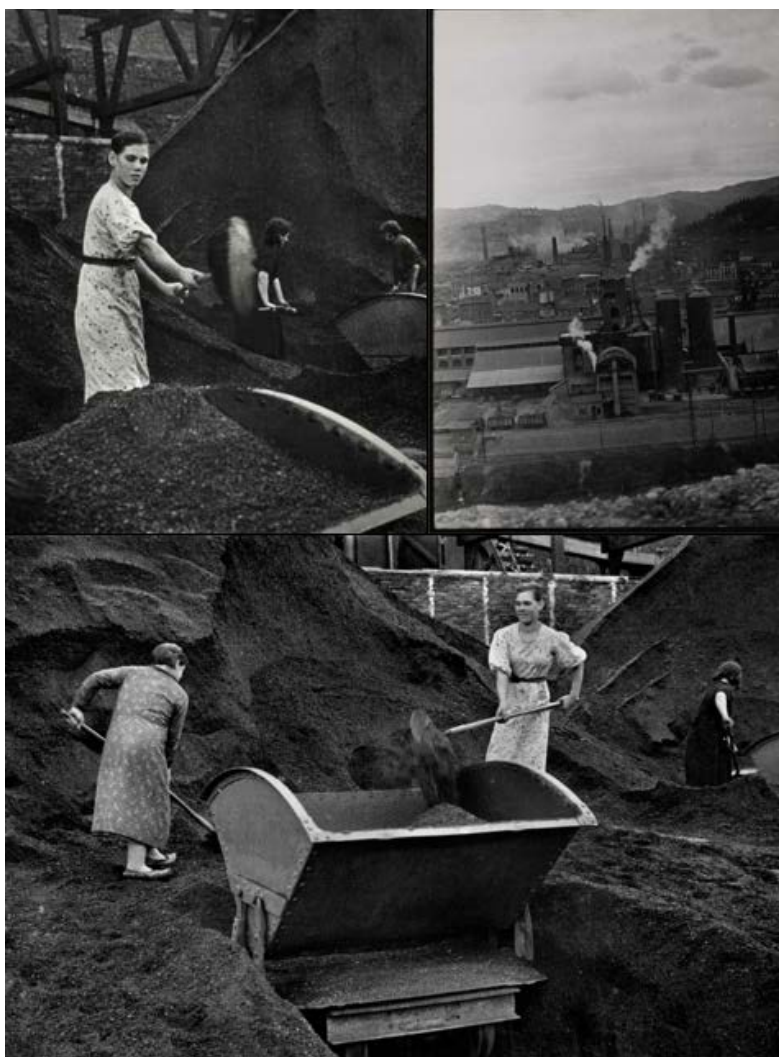
Mujeres trabajando en la zona minera de Langreo y vista de Duro Felguera. Finales de enero de 1937. David Seymour 'Chim'
